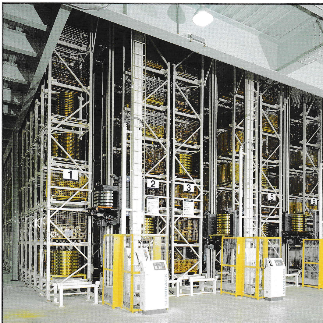
●自動立体倉庫〔住友重機械工業(株)製〕
